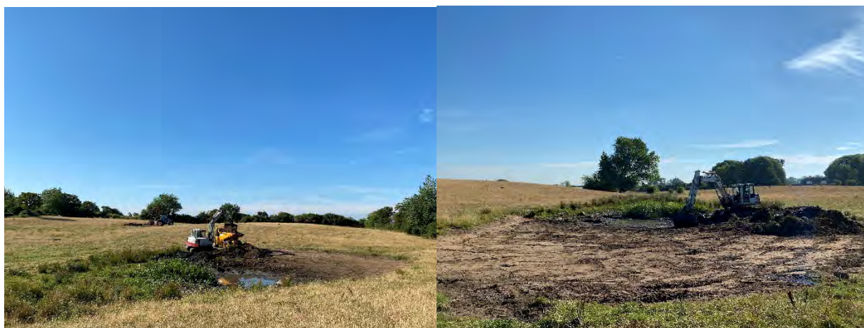
Vandhul 1: Gravning af nyt vandhul på jord, hvor der er opkøbt dyrkningsrettigheder
