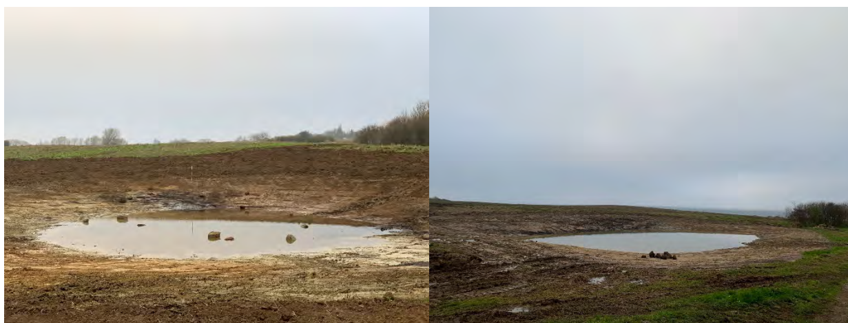
Vandhul 2: Gravning af nyt vandhul , på jord hvor der er opkøbt dyrkningsrettigheder
