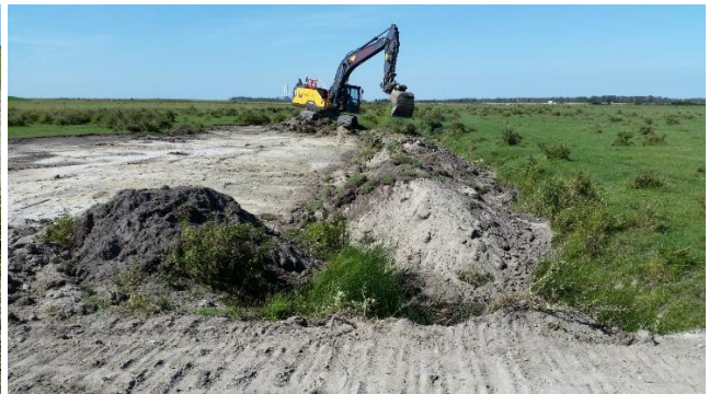
Hævning af bund af grøft til 40 cm under terræn med jord opgravet fra grøftens brinker.
